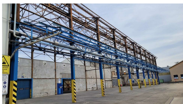
Illustration 4.1: Bâtiment à réhabiliter pour le traitement des fluides frigorigènes - Fin 2023
